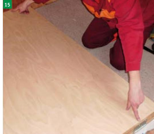
nasazení dřevěného rámu (POZOR panty na rámu musí být na protilehlé straně třímenu uchycené pružin)
