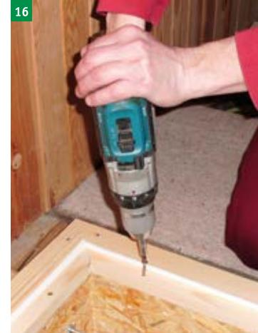
spojení OSB rámu s dřevěným rámem
