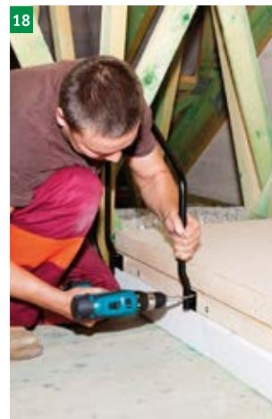
montáž horního zábradlí
