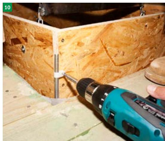
demontáž kotevních šroubů z úchytů
