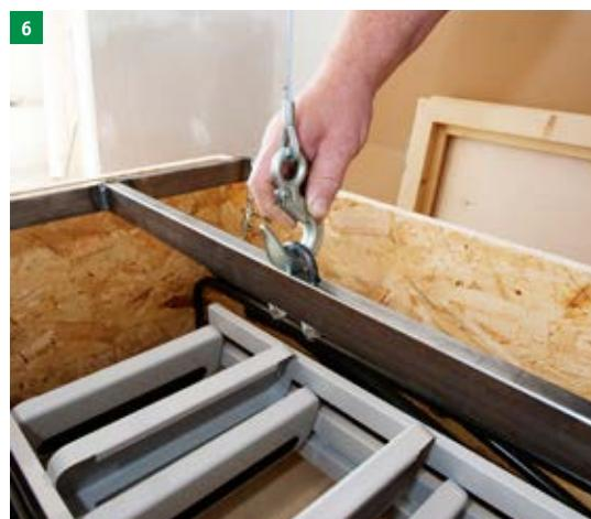
uchycení zvedacího zařízení – nosnost 150kg (není součástí dodávky)
