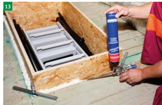
vypěnění mezery mezi schodištěm a stavebním otvorem montážní protipožární pěnou (péna není součástí dodávky)
