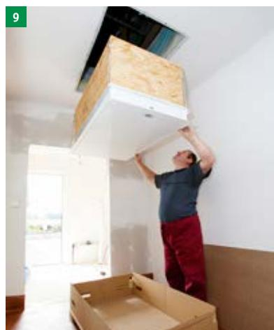
jedna osoba v horním podlaží pomocí zvedacího zařízení schody vyzvedne do otvoru a druhá osoba je zespodu přidržuje a kontroluje dosednutí do otvoru
