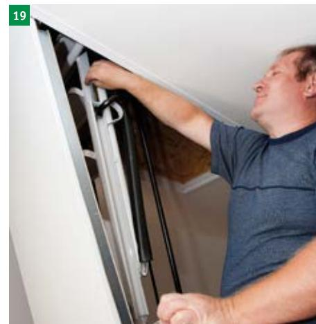
upravení otvírání dolního víka pomocí regulačních šroubů (horní plocha nášlapů musí být rovnoběžně s podlahou)
