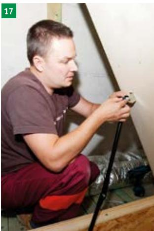
spojení táhel otvírání s horním víkem
